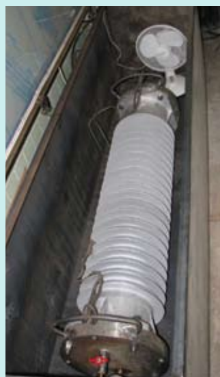
Рис. 2. Испытания покрышки ППТЭ-110-4 УХЛ 1 на интегральную утечку элегаза
