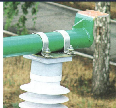
Рис. 3. Современные шинодержатели типа «скоба» различного типоразмера
