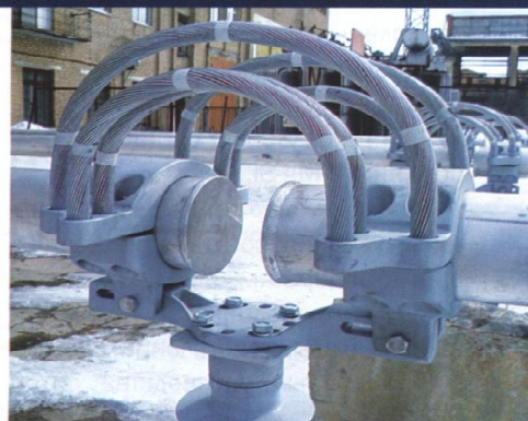
б) литые шинодержатели обжимного типа производства испанской фирмы «Arruti Sabestaciones, S.A.»
