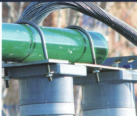
Рис. 3. Современные шинодержатели типа «скоба» различного типоразмера
