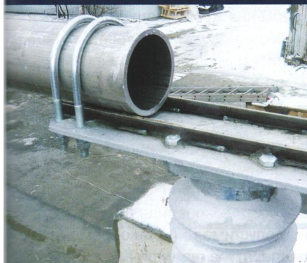
Рис. 3. Современные шинодержатели типа «скоба» различного типоразмера
