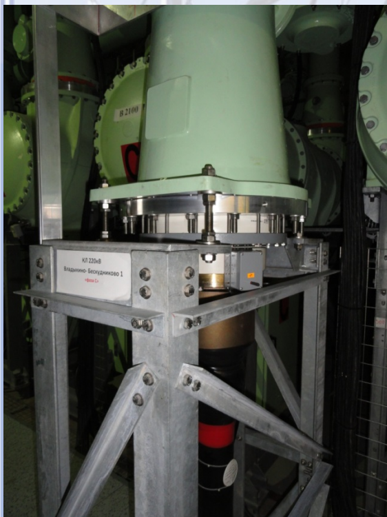
Элегазовое оборудование
