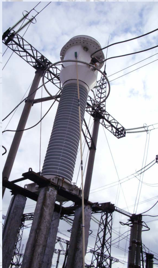
Трансформаторы тока и напряжения
