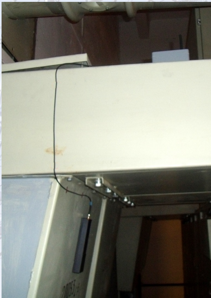
УВЧ электромагнитные датчики и устройство передачи сигнала в ячейках 10 кВ и ниже
