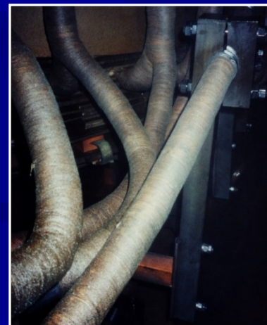
Загрязнение активной части трансформатора силикагелевой пылью
