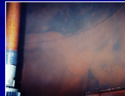
Загрязнение активной части трансформатора силикагелевой пылью
