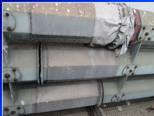
Аномально высокий нагрев токовой перемычки
