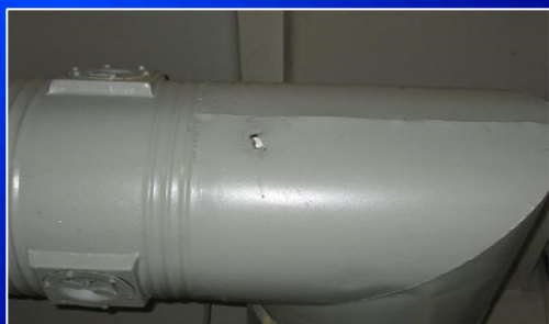
Повреждения экранов
