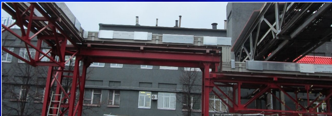
Трасса токопровода ТКЛ
