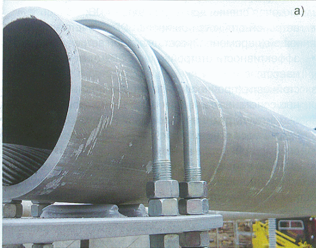
Рис. 2. Современные шинодержатели: а — типа «скоба»; б — торцевой литой обжимного типа; в — проходной литой обжимного типа
