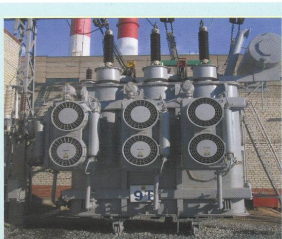
Рис. 1. Трансформатор ТДЦ 125000/110
