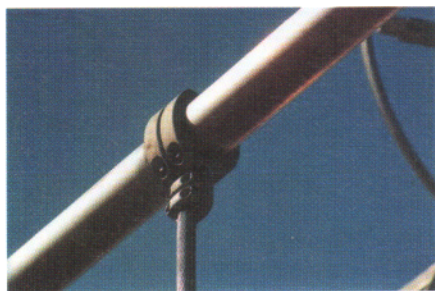
Рис. 4. Крепёжный узел ответвления
