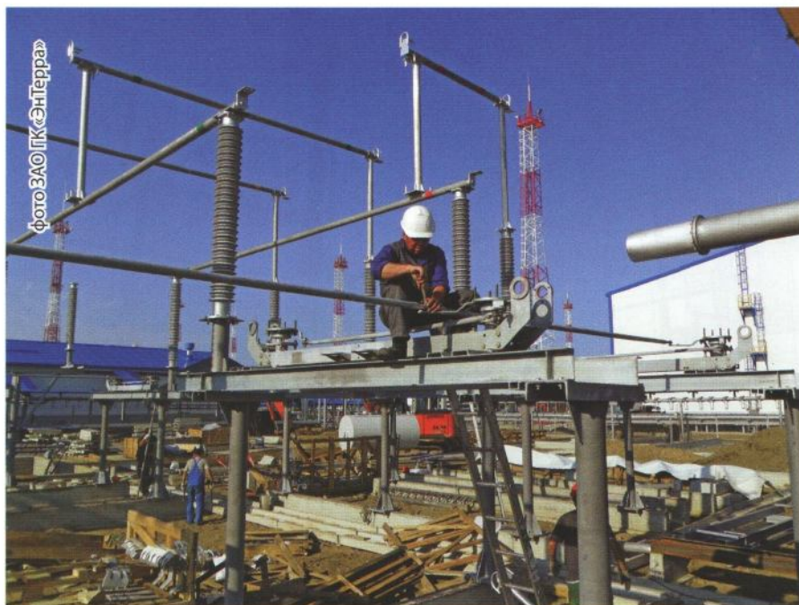
Монтаж жесткой ошиновки на ПС 220 кВ «НПС-14»
