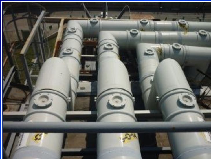
Обследование каждого пояса изоляторов токопровода акустическим и индукционным методом приборами AR200 и R400
