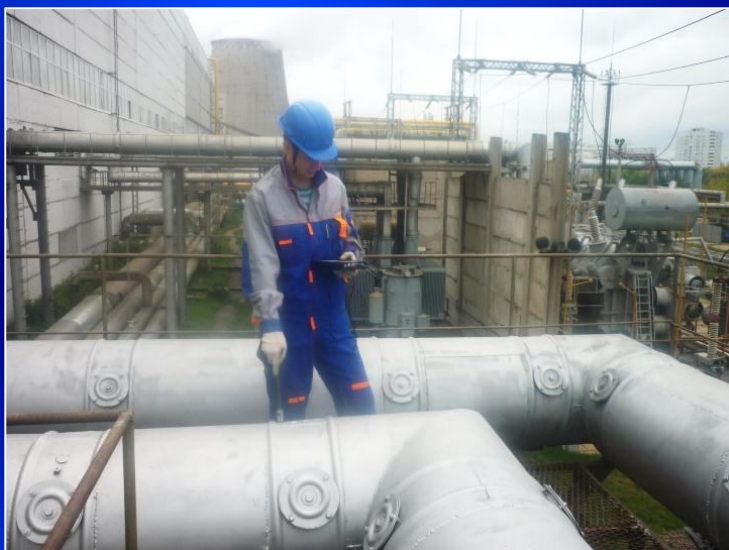
Обследование каждого пояса изоляторов токопровода акустическим и индукционным методом приборами AR200 и R400
