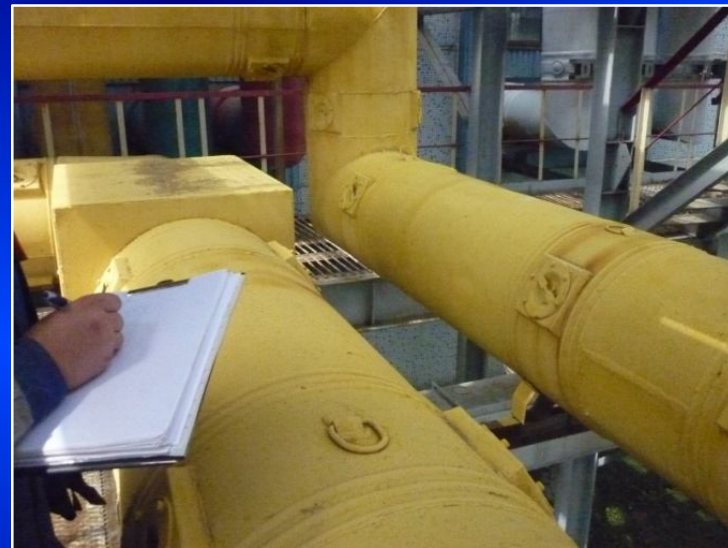
Обследование каждого пояса изоляторов токопровода акустическим и индукционным методом приборами AR200 и R400
