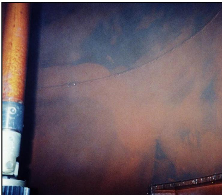
Рис.1 Налет силикагелевой пыли на изоляции активной части трансформатора АТДЦТН 125000/220/110
