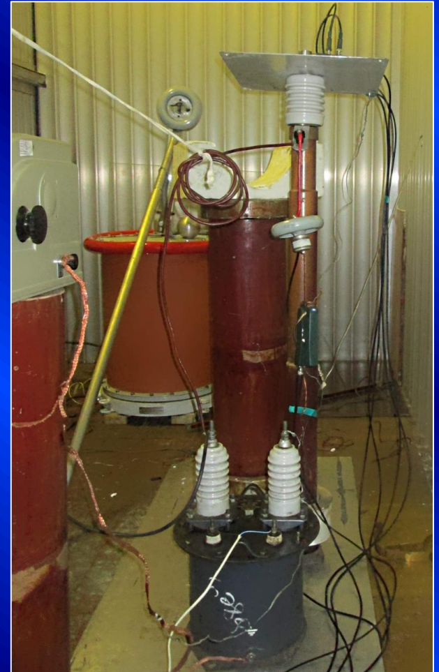
Установка датчиков на экране
