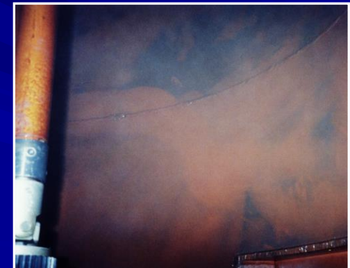
Загрязнение активной части трансформатора силикагелевой пылью
