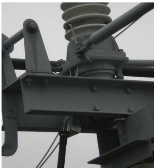
Рисунок А2 – Установка наконечников щупов блока регистрации на пластину крепления нижнего фланца изолятора
