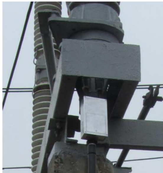
Рисунок А2 – Установка наконечников щупов блока регистрации на пластину крепления нижнего фланца изолятора
